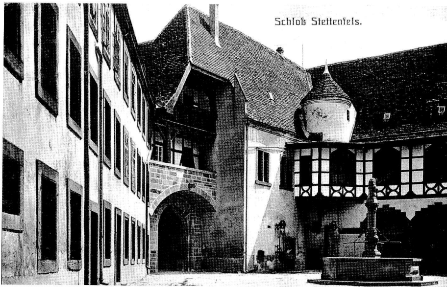
Innenhof des Schlosses: Links Offiziantenbau, rechts neben dem Eingangstor die Arkade mit dem Gang darüber.
